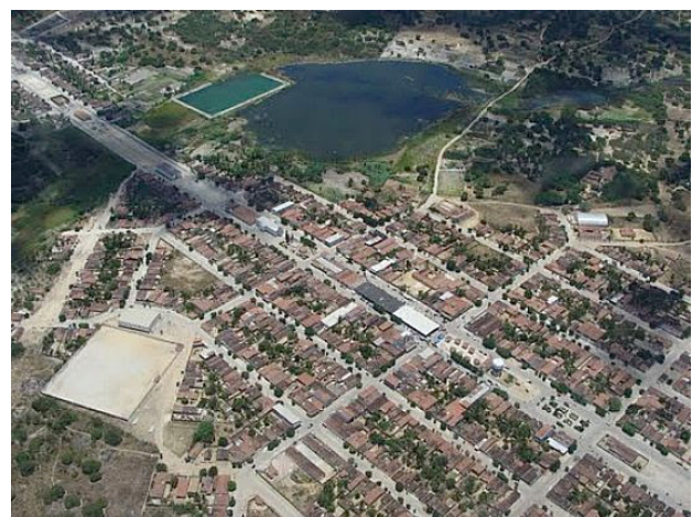
Figura 1 - Imagem aérea da cidade de Lagoa Nova/RN.
